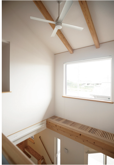
天井のファンで屋内の空気を攪拌し、温度ムラなく快適な室温を維持。FIX窓からの光は1階を明るくする
