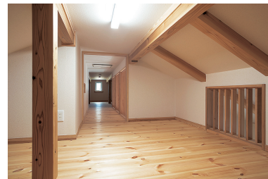
奥に長い小屋裏収納。右の縦格子を付けた開口部から空気が出入りし、夏は熱い空気が排出されて適温に
